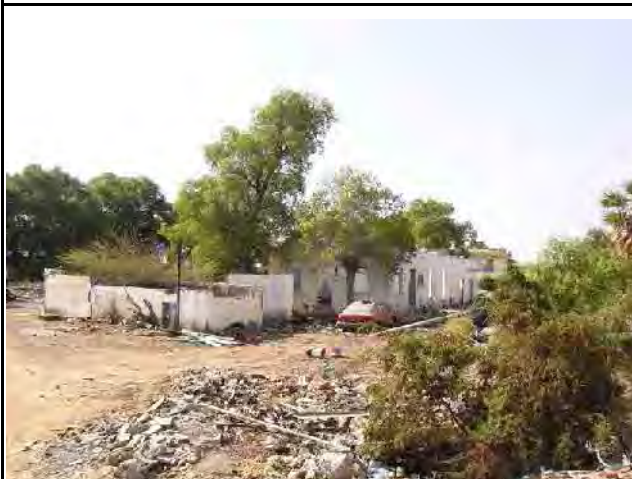
1. 建設予定地(2009年6月撮影) 敷地内には古い建物や、基礎、廃棄物等が散在していた。また、建設予定地は周辺よりレベルが低いため、盛土が必要である。
