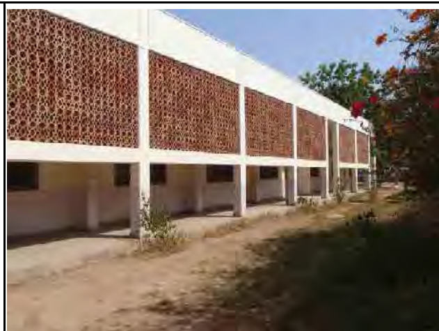
14. フクザワ中学校(一般無償) 朝夕の強い日射が室内に差し込むのを避けるため、窓の外側に日除け用のスクリーンを設置している。朝夕の強い日射が室内に差し込むのを避けるため、窓の外側に日除け用のスクリーンを設置している。
