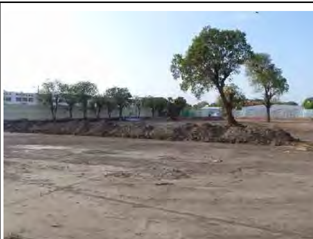
2. 建設予定地(2010年2月撮影) ジブチ国側により敷地内の障害物の撤去工事が開始されていた。引き続き、古い基礎の撤去と盛土が必要。
