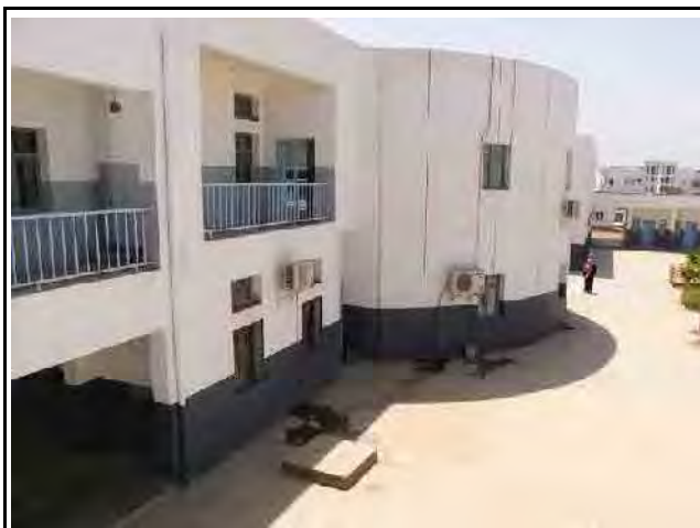
19. GABODE高校 (FADES資金) 完成後2年しか経過していないが、施工不良等が多く、不具合が多く発生している。
