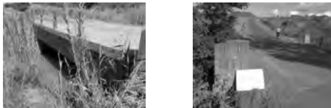
Foto 1.3.6 No.17-Ponte Namiungu (esquerda) e No.21-Ponte Luelele (direita)
