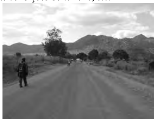
Foto 1.2.2 Secção de Melhoria Pontual (60km)
