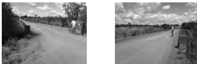
Foto 1.3.4 No.10- Ponte Lussengessi-I
