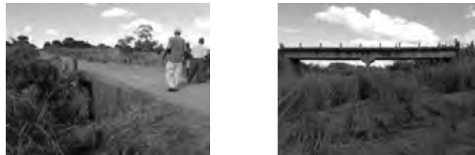
Foto 1.3.6 No.13-Ponte Ngolua (esquerda) e No.14-Ponte Ngame-II (direita)
