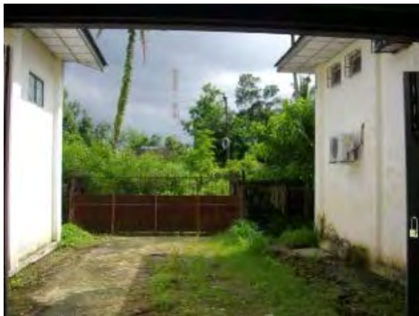
中央結核倉庫。搬入用車両の駐車スペースは 4t トラック 1 台分程度。
