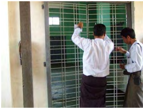
中央結核倉庫。出入り口は施錠されておりセキュリティはよい。
