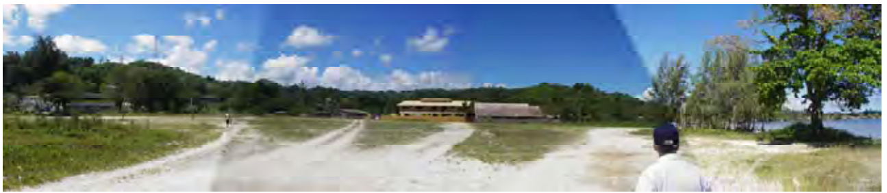
写真-2：新市場建設予定サイトを西側(棧橋側)より望む。市場建設サイト周辺は空地となっており施設建設の際のヤードに利用される予定となっている。
