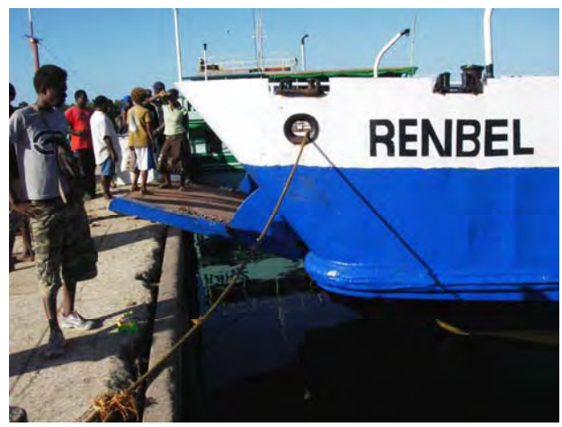
写真-5:既存栈橋はフェリーランプを備えておらず、フェリー船のフラップの取り付けにより栈橋端部が損傷する等の不具合が見られる。
