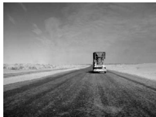
片側完了、左側は未完了 (マリ郊外)
