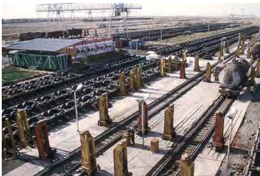
台車交換施設、サラフス
