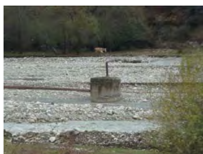
4. 7km 地点集水埋渠の接合井
