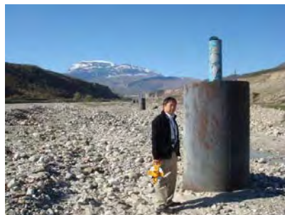
2. 新 18km 地点集水埋渠の接合井
