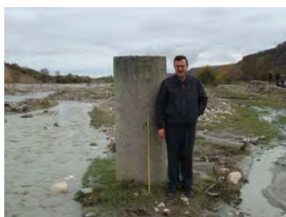
5. 5km 地点集水埋渠の接合井
