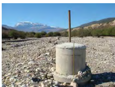
3. 15km 地点集水埋渠の接合井
