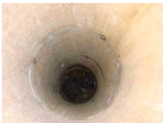
接合井の内部
