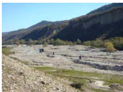
1. 18km 地点集水埋渠の接合井群
