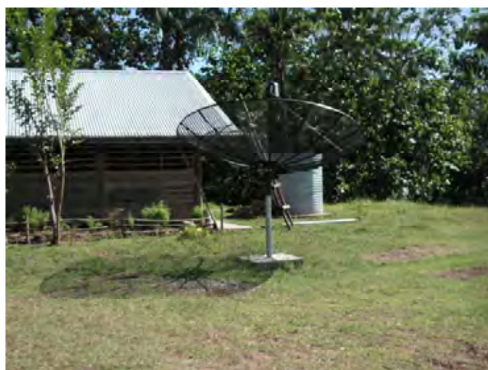
⑨テレビ受信用パラボラアンテナ 衛星放送送受信用のパラボラアンテナで、地上波の届かない地域ではこれが必要。
