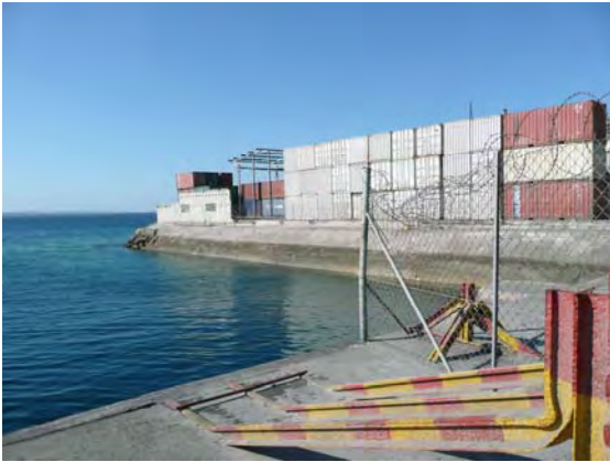
隅角部もコンテナ置き場
