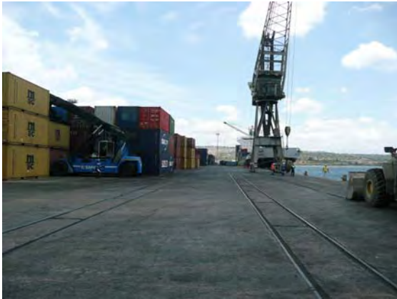
トップリフターによるコンテナ荷役(3段)
