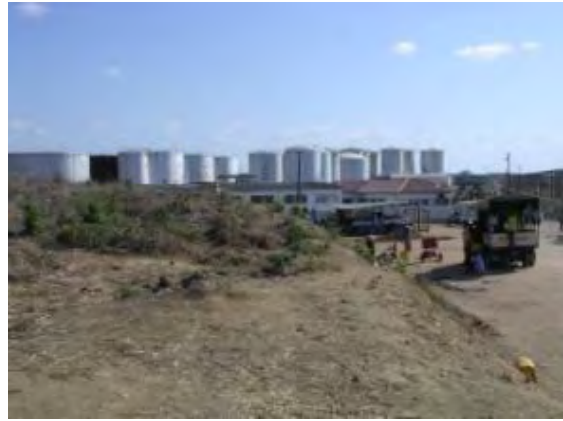
写真8 ナカラ港より約2km離れた民間石油タンク
