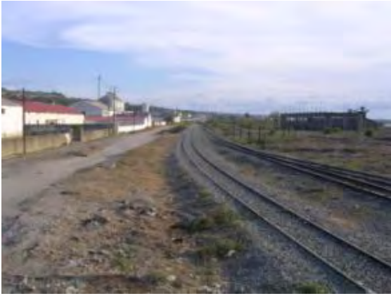
写真7 ナカラ港からマラウイまで伸びる鉄道
