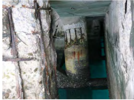
コンテナ埠頭のコンクリート杭及び床版の鉄筋露出・腐食、杭(直径750)ピッチ600
