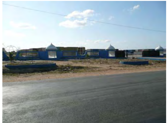
ドライポート(空コンテナ置き場)
