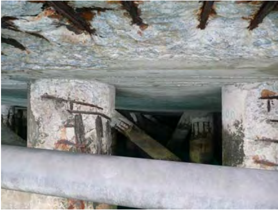
コンテナ埠頭のコンクリート杭及び床版の鉄筋露出・腐食、杭(直径750)ピッチ600
