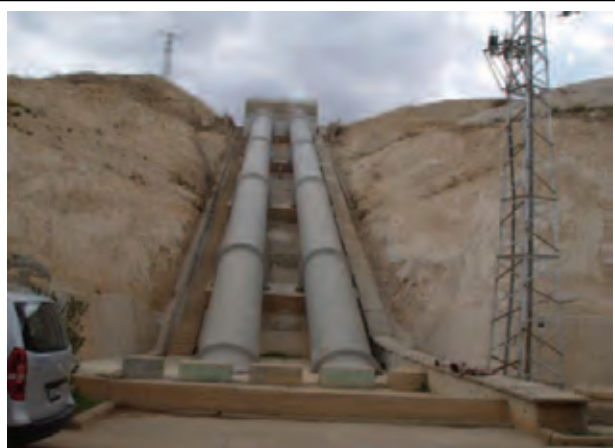
アサド湖を水源とする、東メスケネ国営事業ポンプ場からの幹線水路への送水管、1995年稼動開始、揚程約80mを有する。（ラッカ県）
