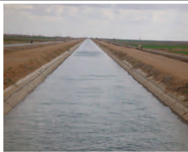
東メスケネ幹線水路：計画設計流量 25 m^3/s により、1万7,000haを灌漑する。視察時約 11 m^3/s を送水していた。（ラッカ県）
