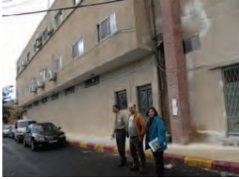
保健省 医療器材保守局がある建物
