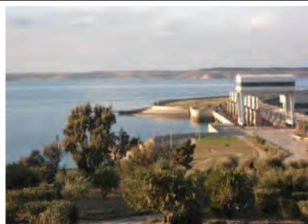
ユーフラテス・ダム（アサド湖）の右岸側にあるダム公団(GOED)より望む。1978年完成、貯水量141億 m^3 を有するシリア最大のダムである。（ラッカ県）
