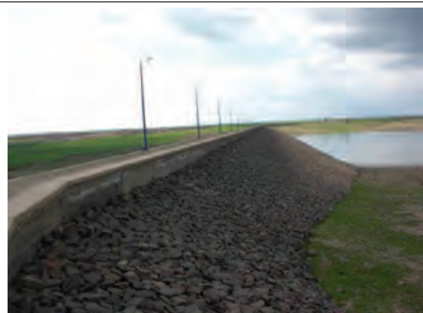
トルコ国境近くのカブール川支流に1974年に建設された Al Jawadia ダム：旱魃の影響で、有効貯水量の最低水位を下回っている。(ハッサケ県)
