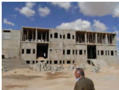
ハッサケ県 シャッターディ病院 (60床) (2010年完成予定)
