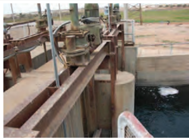
1978年に灌漑が開始されたアサド国営事業（灌漑面積2万1,000ha）の幹線水路分水施設：老朽化が進み、ゲート操作に支障を来している。（ラッカ県）
