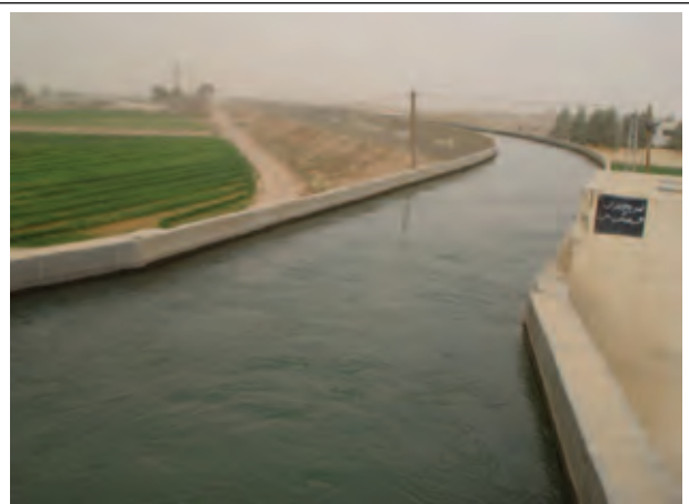
カブール川導水路 (仮称)：1990年頃以降のカブール川の枯渇現象に伴い、建設された。ユーフラテス川の水をポンプ揚水し、カブール川に沿って上流方向へ導水しつつ、周辺の農地を灌漑している。(デリゾール県)
