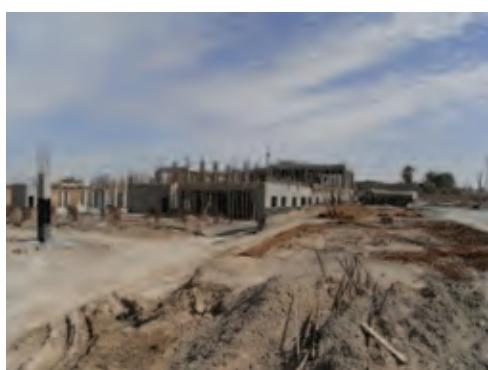
ラッカ県 マーダン 60床総合病院 (2010年完成予定)
