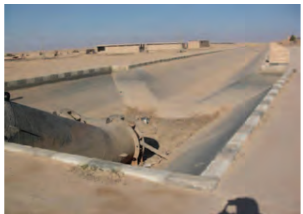
左写真のカブールダムに付随する幹線水路：ダムの貯水量不足から、灌漑できない状況が2年間続いている。(ハッサケ県)
