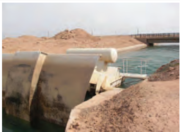
ユーフラテス川左岸側 Balikh-5 国営事業の幹線水路：2008年完成の新しい水路で、フローティング・タイプの流量制御ゲートを採用している。（ラッカ県）
