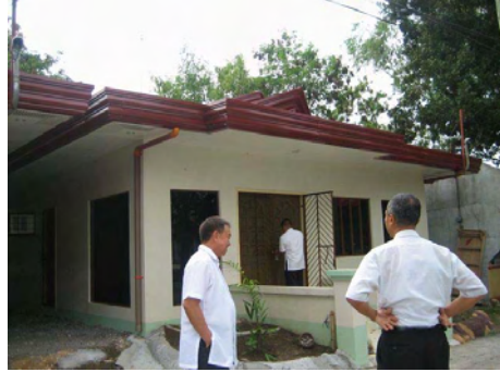
完成したコンピューター施設
