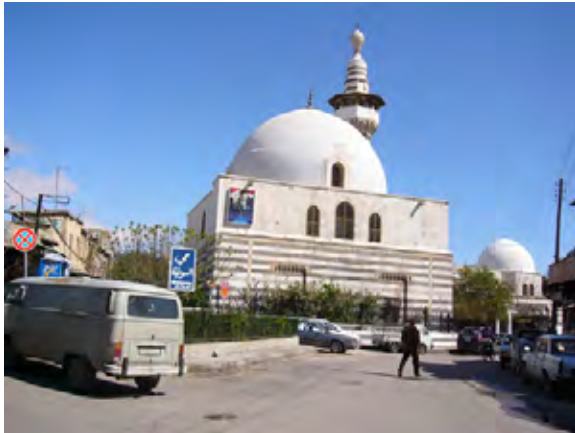
地区東南端のオープンスペースとモスク
