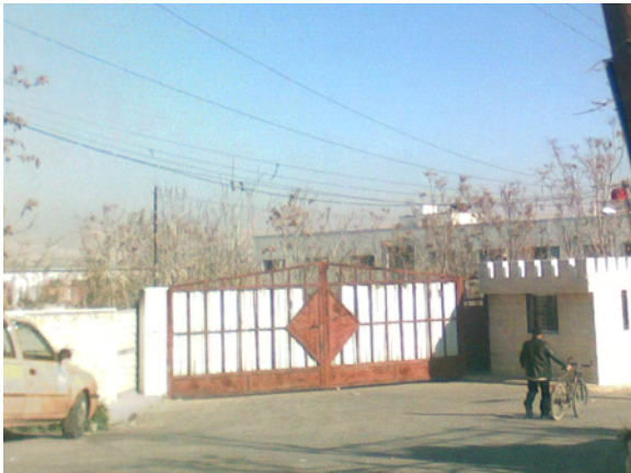
ゴータ・ロード沿いの工場
