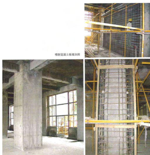
加固后的框架柱
