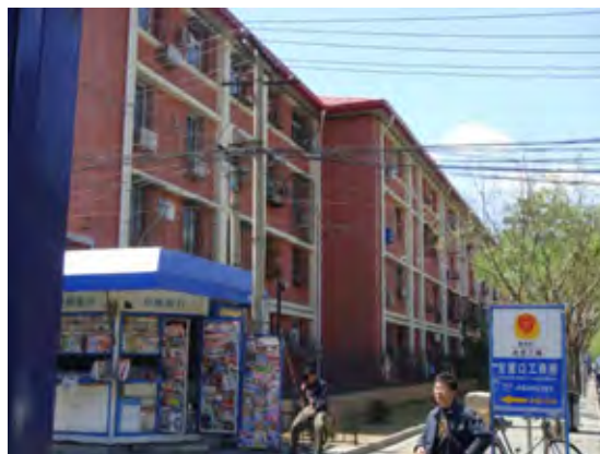
写真 2-4 耐震補強された 1980 年代建設のレンガ組積造集合住宅（北京市海淀区）
