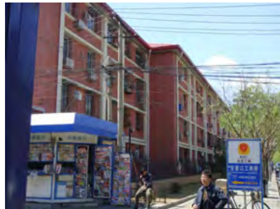
耐震補強 (白色の骨組) された 1980 年代建設のレンガ組積造集合住宅 (北京市)
