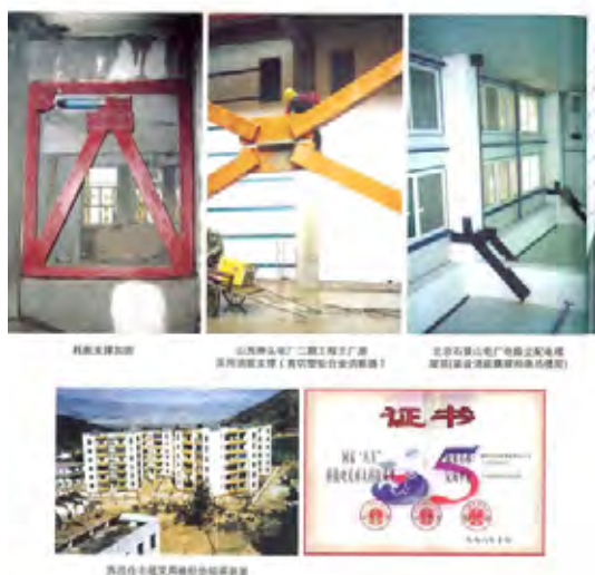
写真2-11 制震部材(上)と免震構造住宅(下)
