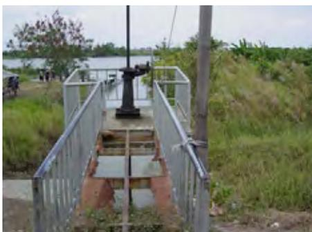
床板が破損している取水設備
