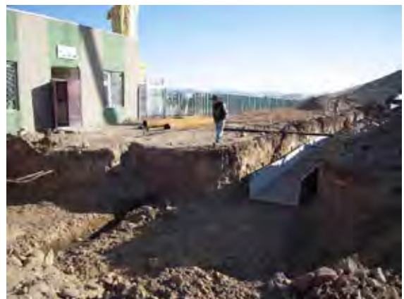
同左、温水暖房配管の工事状況。コンクリート製のカルバート内に敷設され、プロジェクトサイト反対側の事務所ビルに接続されている
