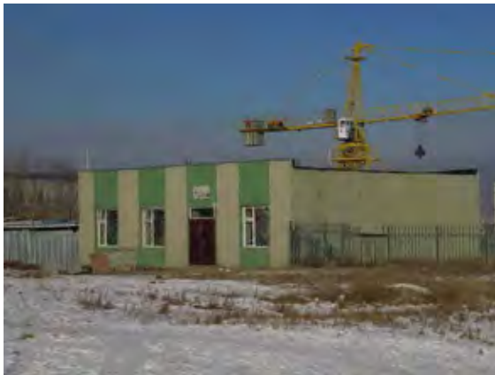
プロジェクトサイト北側にある温水暖房ポンプ小屋は民間の所有であるが、新センターへの分岐が予定されている
