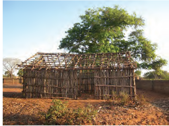
新設中の待合室
