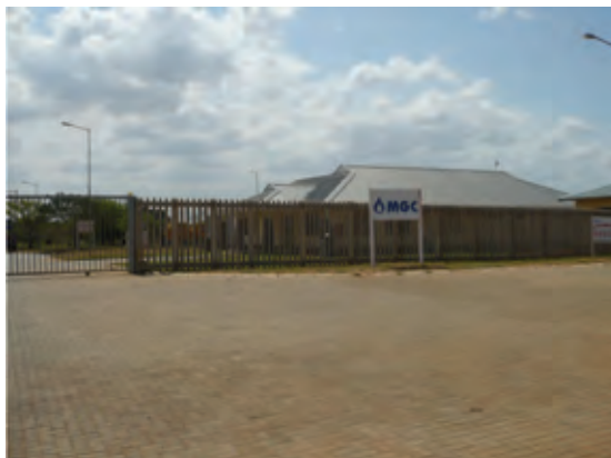
ポンベ充填設備入口
