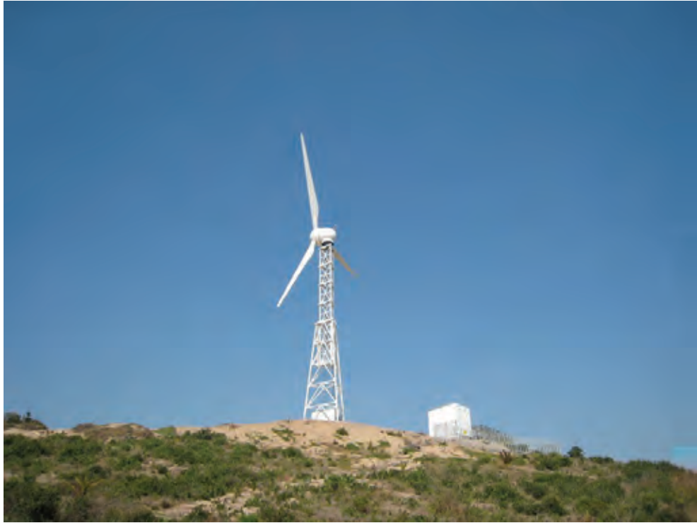
写真 5 - 1 Rocha 海岸付近に設置された 300kW の風力発電設備 (1)
