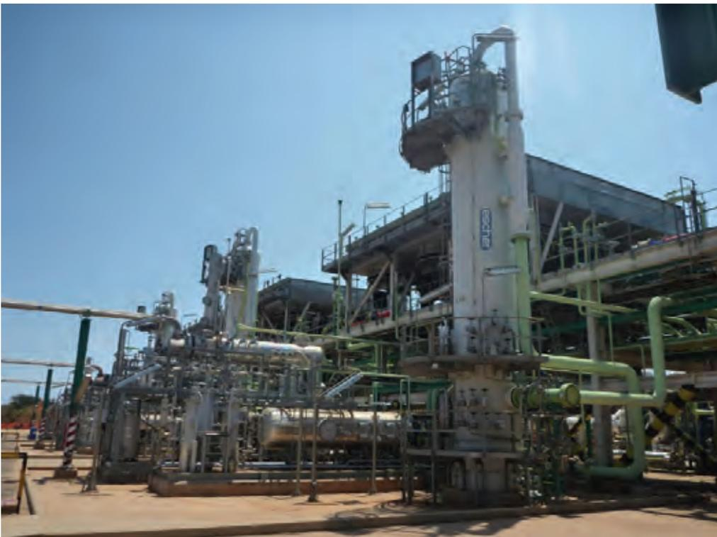
写真4-3 セパレーター及びコンデンサー
