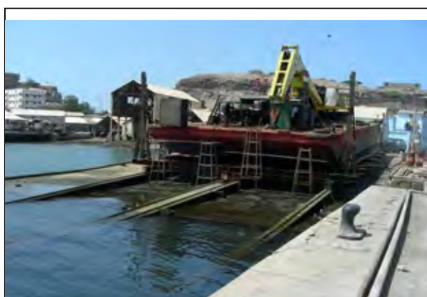
写真 5-7 Yemen Gulf of Aden Ports Corp.の船台
