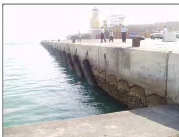
写真 5-3 Ma'allah Wharf ・ RoRo 岸壁
