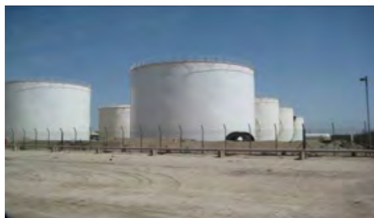
写真 3-15 オイルターミナルのタンク
