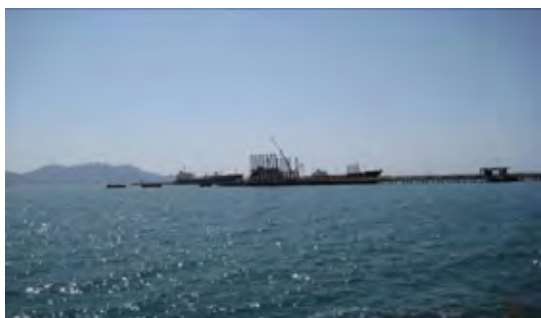
写真 3-14 オイルターミナルの栈橋
