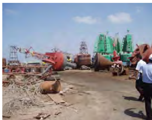
写真 3-20 造船所敷地内で整備中の灯浮標
