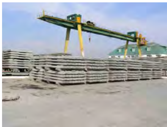
PC 枕木工場 (ストックヤード)
