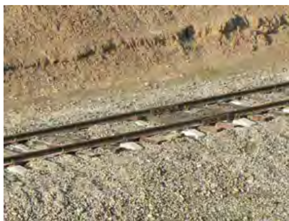
木枕木とPC 枕木が混在した軌道
