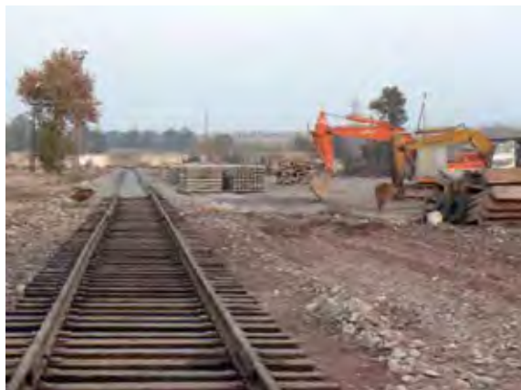
(a) 新線建設現場（その1）
