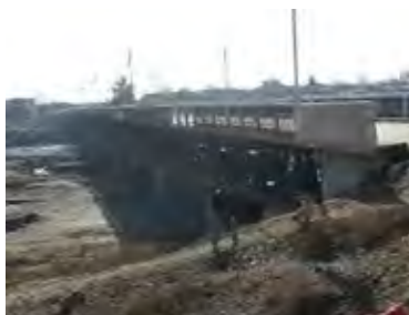
シャフリトス入口の橋梁
