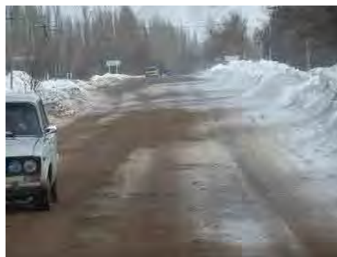
除雪による道路幅員の減少
