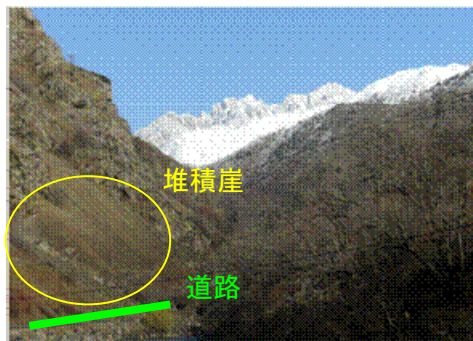
堆積崖下通過 (法面保護なし)
