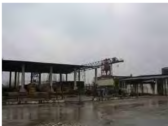
Paivand 社 PC 桁製作ヤード
