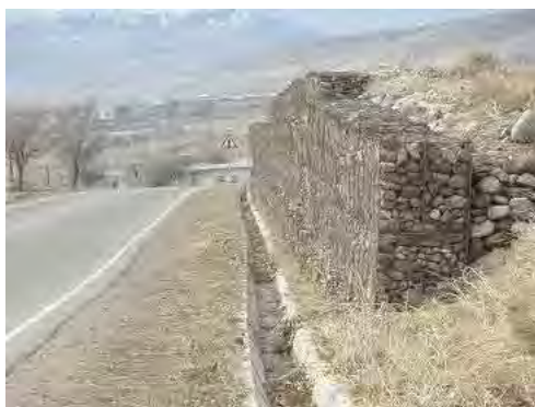
防護壁（蛇籠工）
