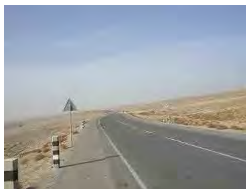
日本整備区間 IR11 ニジノピヤンジ付近
