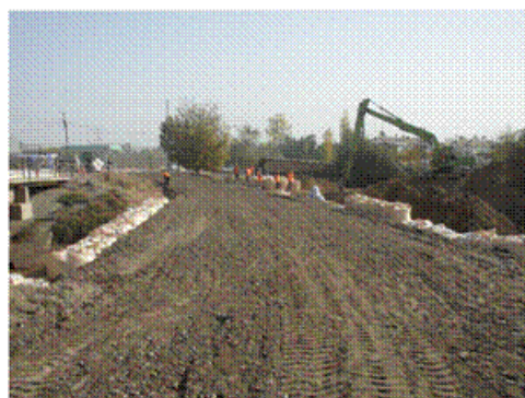
クルガンチュベ～ドゥスティ間橋梁切り回し道路工事
