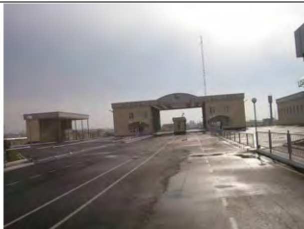
写真-2: 新国境税関施設のカザフスタン側からの外観 完成した税関施設において、越境する人、輸出入貨物、および通過貨物に対する税関業務を行う予定。
