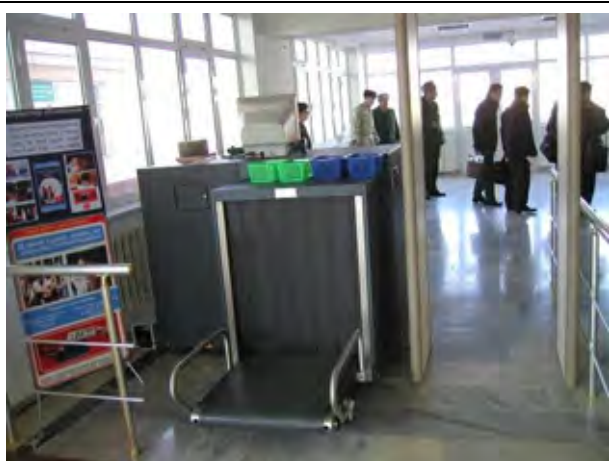
写真-5: 手荷物用X線検査機材ほか 越境する人は、金属探知機(写真右手の門型の装置)による金属探知検査、所持している荷物については手荷物用X線検査機材(Smith Heimann製、74168型)による、X線検査が行われる。
