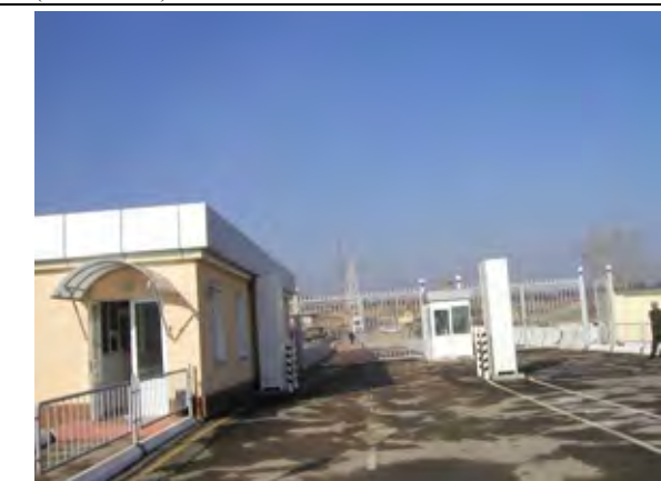
写真-3: 放射線検査 ポータルモニター(写真の白色の四角柱の中に設置されている)により、越境するトラックやコンテナなどの車両を通過させて、ウランウムなどの放射性物質の有無を監視している。
