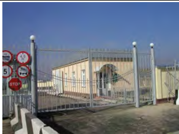
写真-2: 国境税関施設 タジキスタン側から見た税関施設。写真右手の建物は、越境する人(車両の運転手や同乗者を含む)が入管手続き、検疫やポータルモニターによる放射線検査などを受ける。
