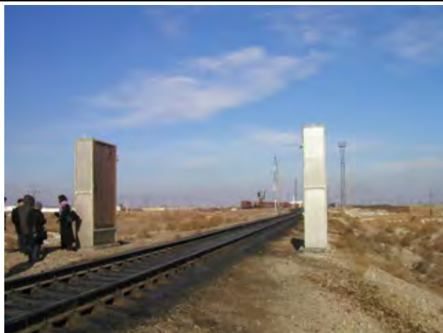
写真-1: ホジャダブラ駅 ブハラ市郊外にある、トルクメニスタン国境から約11kmの鉄道税関。トルクメニスタン、イラン、トルコなどから鉄道を利用した、輸出入貨物の税関業務を実施。軌道の両側に見えるのはポータルモニターで、貨車への放射線検査を行っている。
