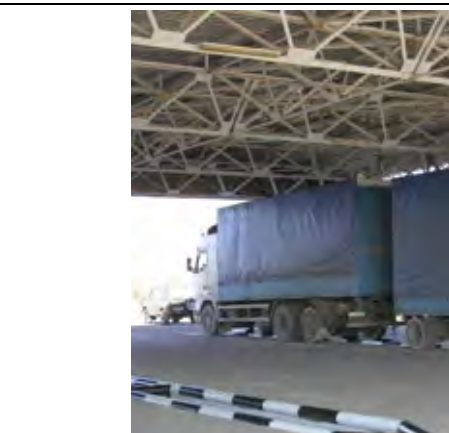
写真-4: 車両の外観検査場 税関職員が、越境するトラックやコンテナなどの車両の車体の外観や(検査済み)シール等の有無を検査し、武器や麻薬などの非合法品の隠匿の有無を目視と麻薬探知犬で確認する。
