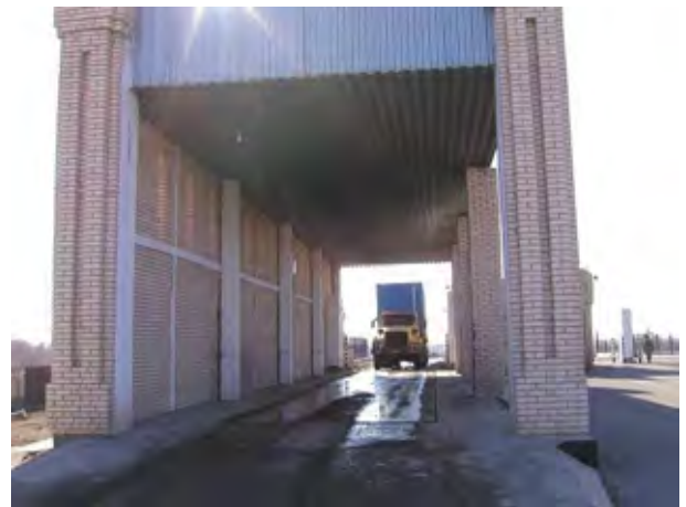
写真 - 2 : 車両重量計(トラックスケール) 道路床面に埋設された車両重量計(写真のトラックの手前)により、越境するトラックやコンテナなどの車両の重量を計測し、重量変化から非合法品などの隠匿の有無を確認する。
