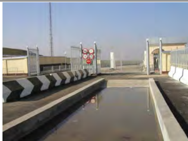
写真-4: 車両のタイヤ消毒 税関施設内に設備されており、「ウ」国に入国する車両(トラック貨物、コンテナ貨物等)はすべて、この殺菌水溜まりを通過して、タイヤ消毒が行われる。
