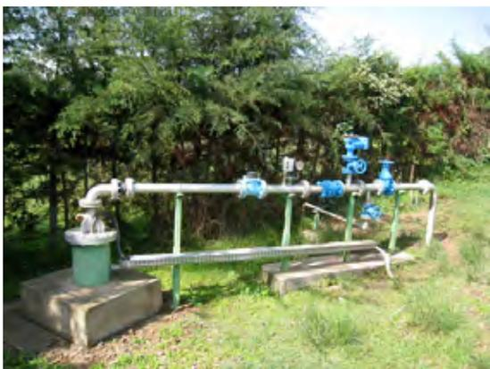
Arsi Negele ウェルフィードの井戸：タウン東方 7km 地点に 6 本の深井戸を掘削しタウンへ給水。深度 230m
