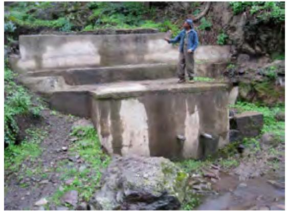
Wolonkomi の湧水取水施設：東部台地の Hetosa ワレダに属するルーラルタウンの水源である。雨期のため越流がある。
