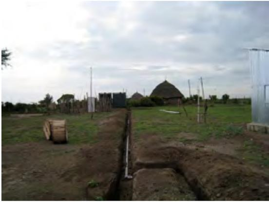
**Aje** タウン西方の給水施設：この地点では深度 365m の深井戸が掘削され、施設建設中である。
