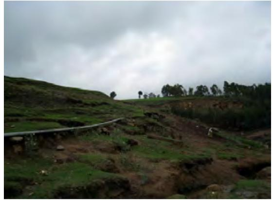
Iteya の送水管：Iteya はリフトバレー北東の台地上にあるワレダタウンであり、湧泉 19.5 l/sec を取水して同タウンの他 4 ワレダに送水している。
