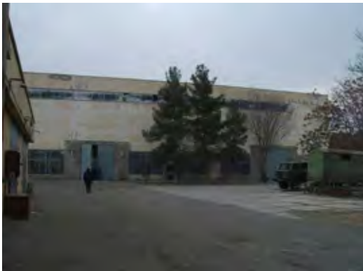
耐震建設研究所。コンクリート・構造研究室の試験所建物。
