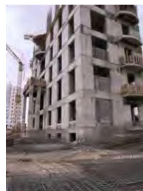
鉄筋コンクリート造建設現場
