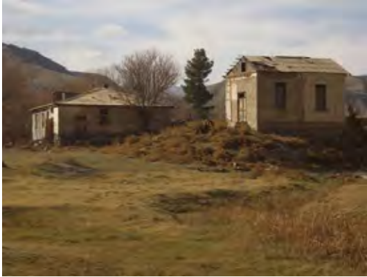
ゲルマップ観測所。 地震計は、向かって左側の建物に設置されている。
