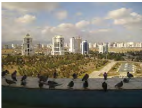
市の南部の高層住宅地。 十分なスペースを確保して高層住宅が建設されている。空地への植林も進められている。
