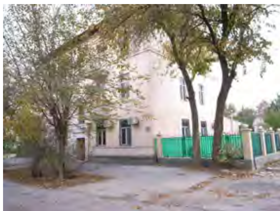
1980 年代に試験的に免震構造として、地下にスプリングを設置した住宅。
