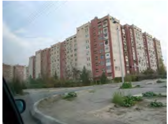
パネル構造 9 階建て集合住宅。
