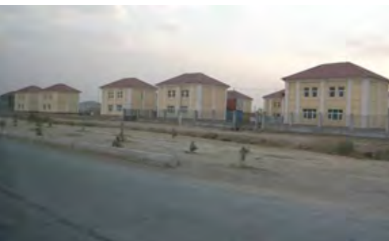
市内北部の開発地域に建設された低層パネル造。
