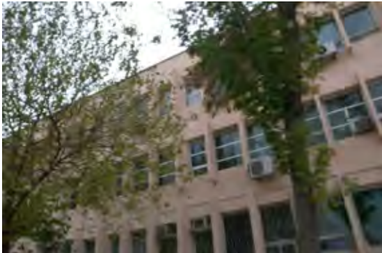
旧鉄筋コンクリート造。
