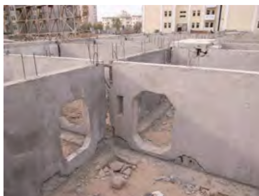
パネル構造集合住宅建設工事現場。基礎部分。
