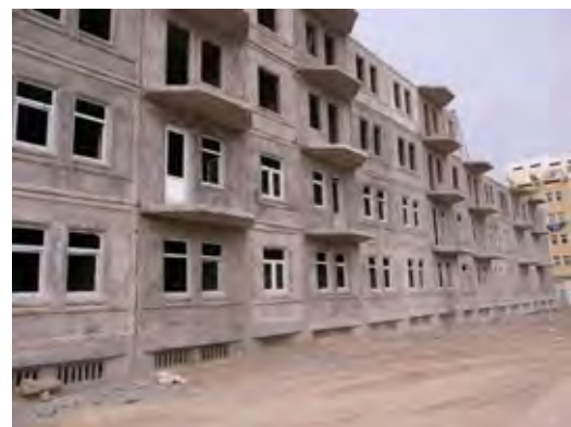
パネル構造4階建て集合住宅建設工事現場。
