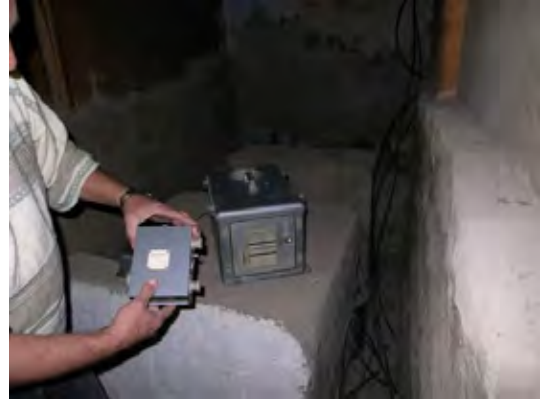
同左。建物内部に設置されている強震計。
