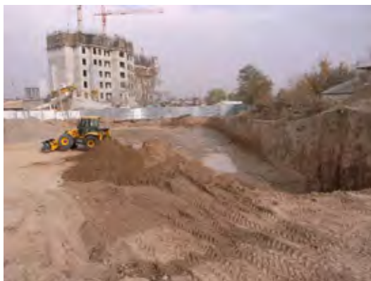
建設基礎工事状況。表層の粘土層の除去作業。
