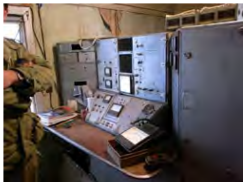
同左。電磁探査用のジェネレータ。 1980年に製作された。22 kv、150 V、160 A の発電能力を有する。
