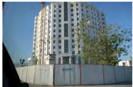
新規鉄筋コンクリート造。
