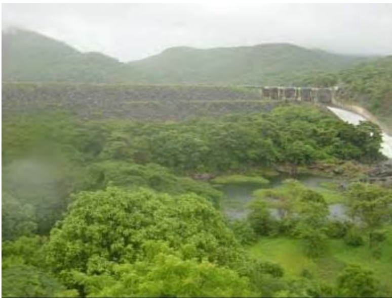
Figure 4.10 Kafue Gorge Dam (photo)
