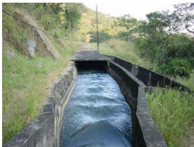
図 10.14 既設 Lusiwasi 発電所導水路
