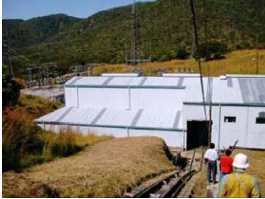
図 10.17 既設 Lusiwasi 発電所
