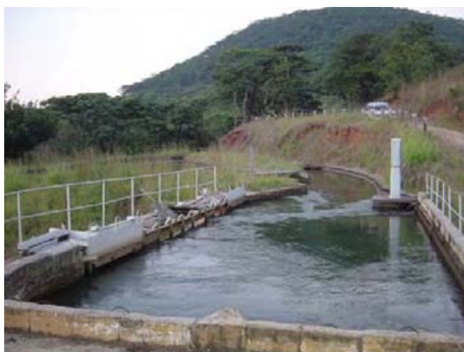
図 10.15 既設 Lusiwasi 発電所水槽
