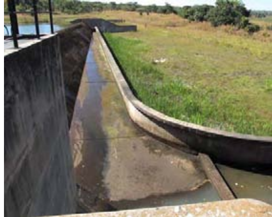
図 10.23 既設 Lusiwasi ダム越流部
