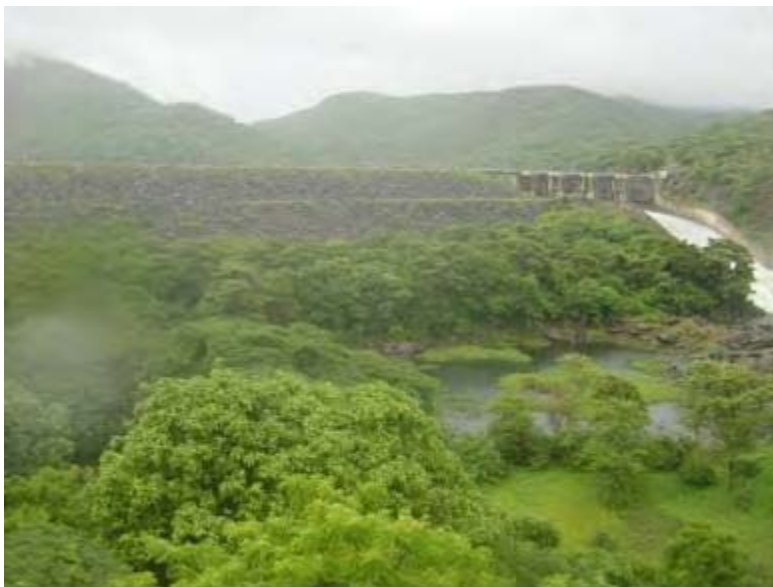
図 4.12 Kafue Gorge ダム (写真)
