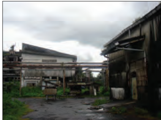
新工学部の建設予定地(ゴア県)
