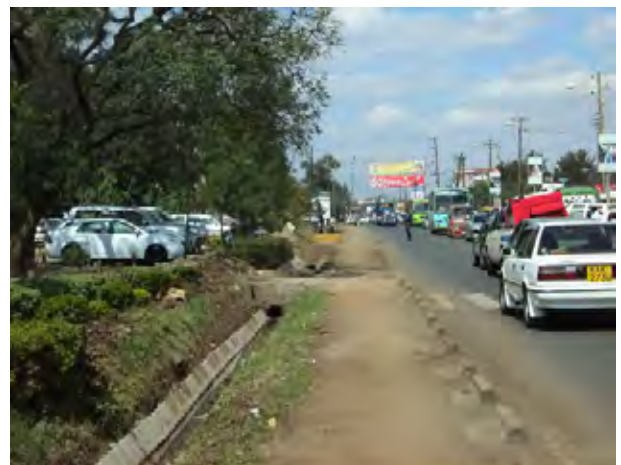
(12) 用地占有：北側の駐車スペースと樹木の占有状況 (S-1)。
