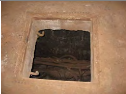
歩道下の地下埋設物
