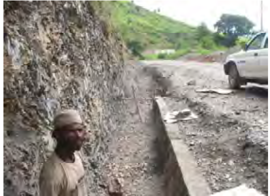
国道山岳部の道路排水側溝の石積状況。
