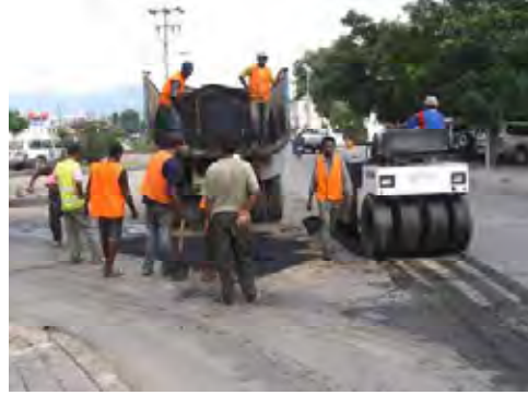
舗装パッチワークに対して0.45m 3 級のバックホウや、転圧ローラーの投入状況
