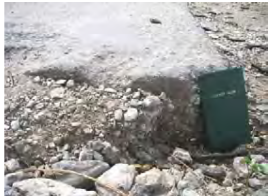
国道の表層舗装断面状況。 ( t=50\text{mm} 、1層)
