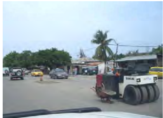
デイリ市内道路の維持管理状況。 ポットホールの補修（表層転圧状況）
