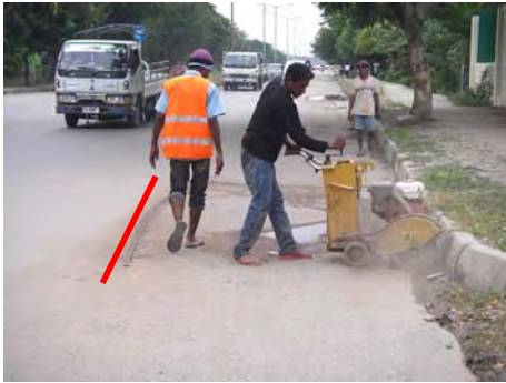
ディリ市内でのアスファルト切断状況
