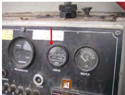
資機材運搬車のアワーメーター（719 時間）
