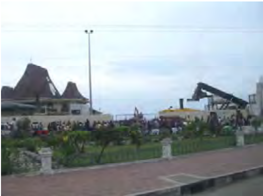
ディリ港の遠景。 港湾内の整備がされておらず、コンテナ 貨物とフェリー乗船客との動線が交差し ている。
