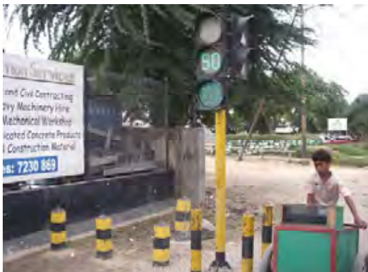
デイリ市内道路の、赤・青2色信号機。 光源はLED式で、灯火時間30～50秒で設 置されている。
