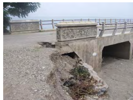
雨季期間中の急激な河川水位上昇による、アバット後背部の洗掘箇所（写真左は、緊急事業）
