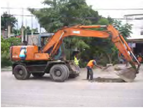
舗装パッチワークに対して0.45m 3 級のバックホウや、転圧ローラーの投入状況
