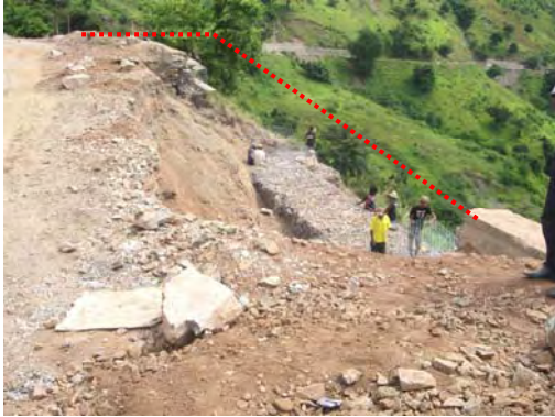
降雨による路肩崩壊の復旧箇所 国道 A-01 号線
