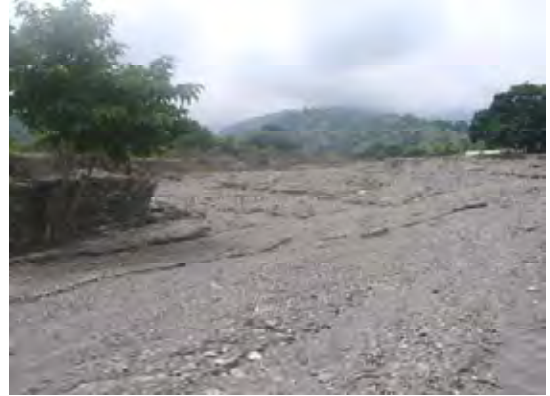
河床の全景。 (河川内の土砂堆積が進行している)
