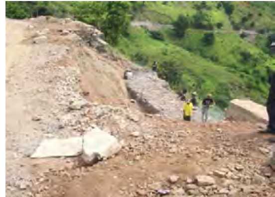
国道山岳部の法面崩壊箇所の補修状況。
