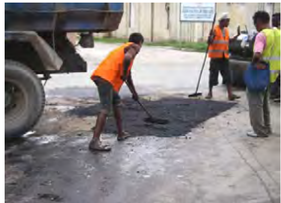
デイリ市内道路の維持管理状況。 ポットホールの補修（アスファルト合材 打替え状況）
