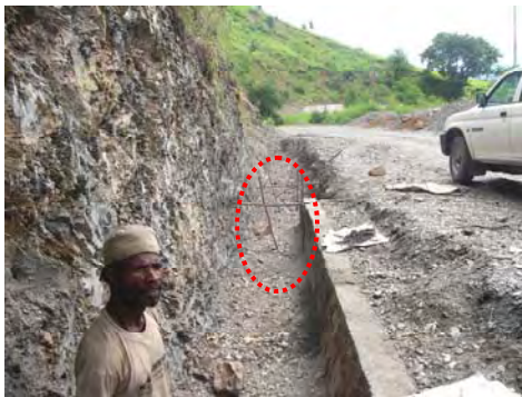
山岳部国道の側溝構築工（練石積工） （丁張りがあるものの断面が小さい）
