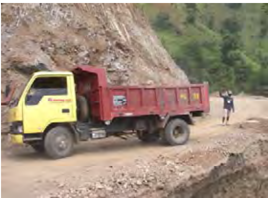
国道山岳部の法面崩壊の状況。
