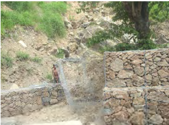
国道山岳部の法尻部の落石防止策。 (蛇籠設置)
