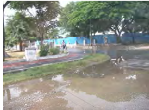
ディリ市内の降雨後の歩車道
