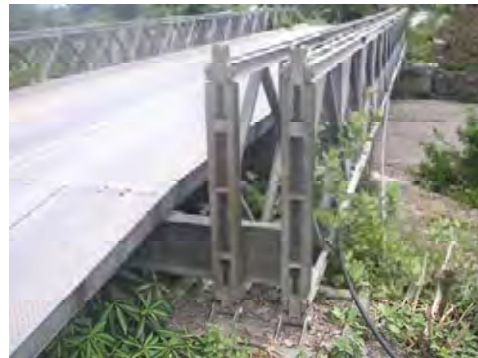
小規模河川に使用されている鋼製桁
