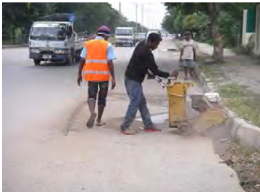
デイリ市内道路の維持管理状況。 ポットホールの補修（アスファルト切断 状況）
