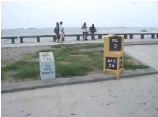
道路距離程（キロポスト原点） 写真左．．． CBRMで設置されたもの。 写真右．．． インドネシア統治時代のもの。
