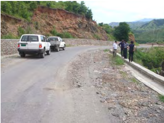
国道山岳部の法面崩壊の補修箇所。道路幅員を広く確保した補修例。
