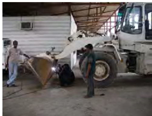
ホイールローダーのバケット補強状況。 バケット底摩擦部の溶接肉付け状況。
