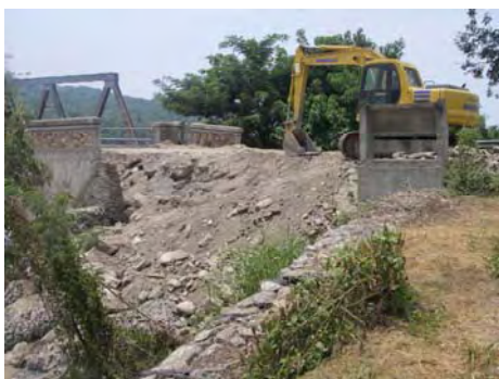
雨季期間中の急激な河川水位上昇による、アバット後背部の洗掘箇所（写真左は、緊急事業）
