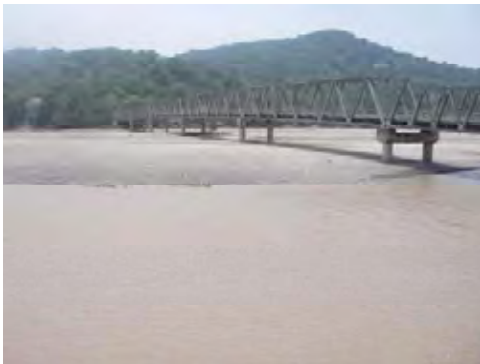
6径間の鋼製トラス橋（1990年竣工）
