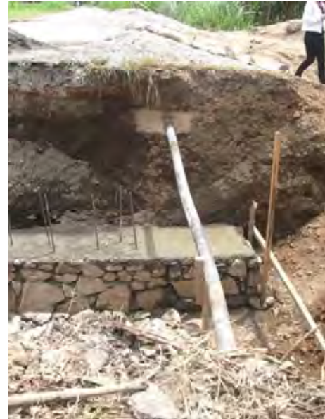
道路埋設物状況。（PVC製水道管） 水道管周りは砂で埋戻しがされている。
