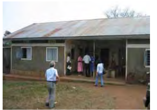
写真-10：サンプル調査にて訪問調査を行った、ナカセケ県ヘルスセンターの外観。
