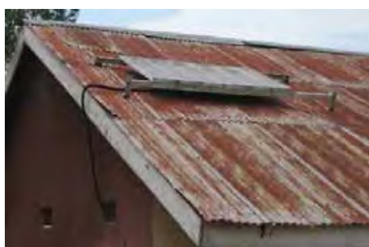
写真-5：ルーフマウント式のソーラーパネ ル。盗難防止用の囲い等の対策はなされてい ない。
