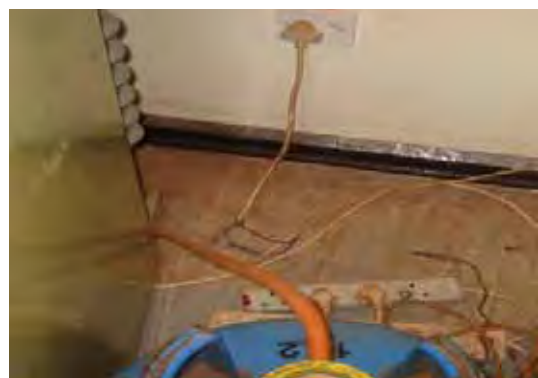
写真-12：冷蔵庫駆動源をガスから電気・ソーラーへ変えることによるコスト削減が必須。
