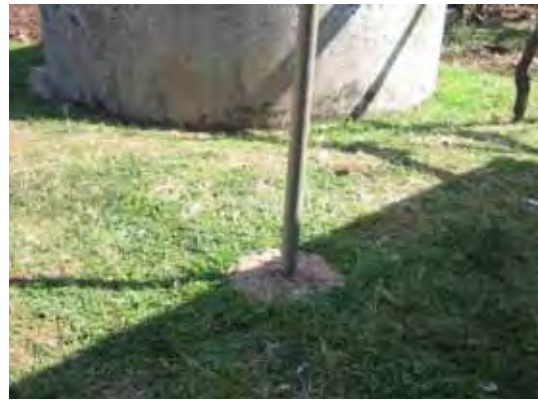
写真-8：ソーラーパネルマウント用のポールはコンクリート基礎により地中に固定されている。
