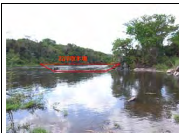
図 10 アヤゴ水力右岸側取水堰地点を 右岸上流から見る
