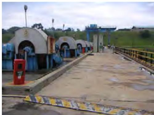
キイラ発電所取水口ゲート巻き上げ機
