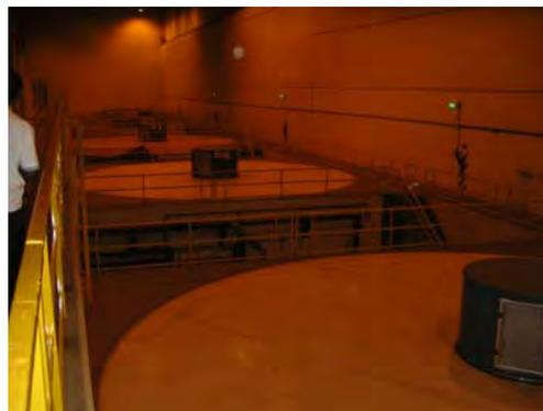
キイラ発電所発電機( 40MW × 10台1号機
