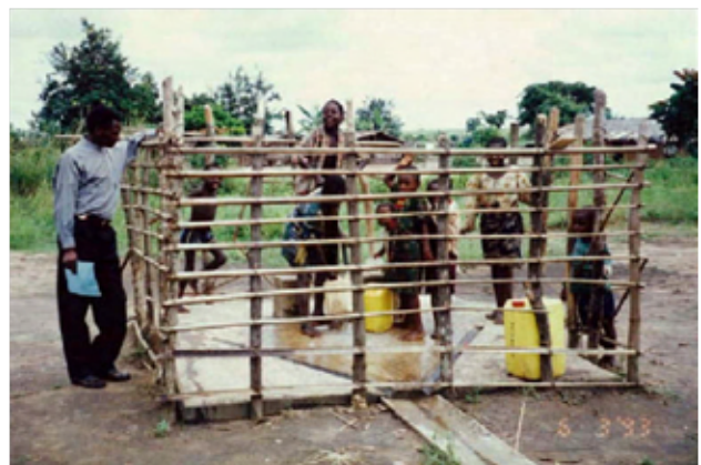
写真 第 1 次無償案件の深井戸施設
