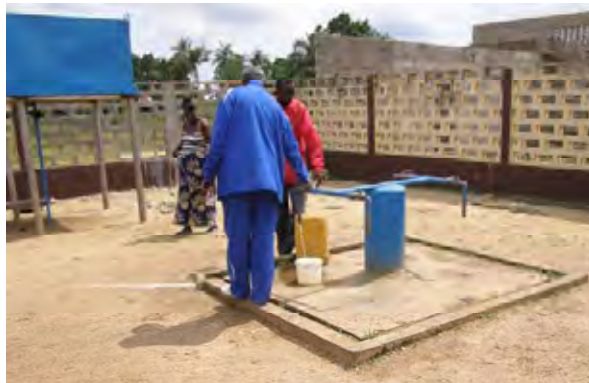
写真 Mengo 村の独立給水所
