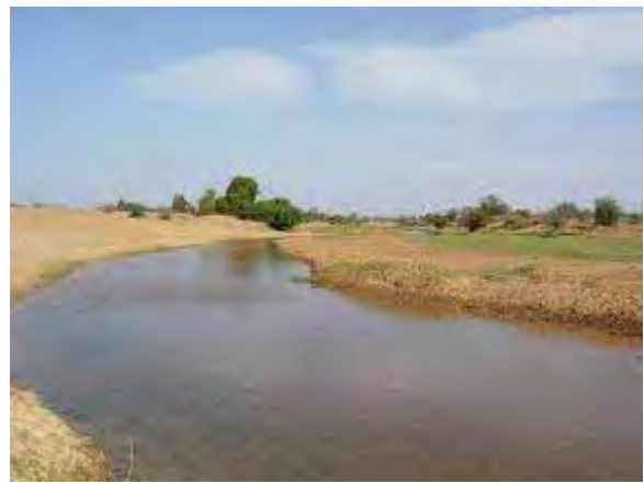
重力灌漑用一次水路（セグー）水路の崩壊や水生植物混入による流量の低下が生じている。
