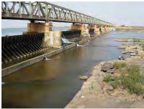
マルカラダム（セグー州）。堰により河の水位を 5m 上昇させ、重量灌漑に利用。
