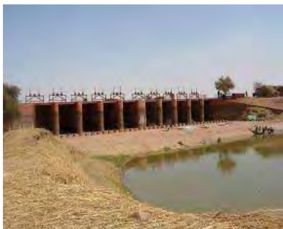
冠水制御型圃場（SC）取水堰。乾季は水位が低下するため、水の流入はない。
