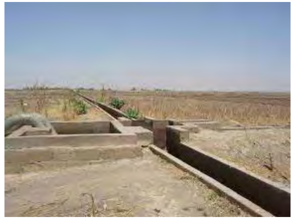
村落型小規模灌漑圃場（PPIV）ポンプによる河からの揚水によって灌漑を行う。
