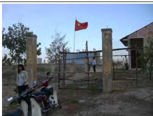
カナダ援助により Quang Ngan コミューンに建設された一般膜処理施設(容量:100 m 3 /日)
