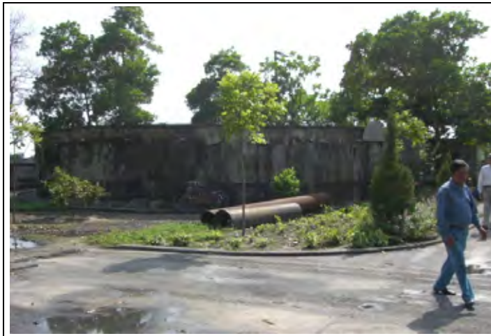
Tram Coc 6 給水中継基地 中継タンク：容量 1,000m 3 G.262 井戸から国道を挟んで南に 約 1km 地点。この送配水ネット ワークにプラント処理水を接続 できる可能性がある。 (撮影年月日:2009年9月23日)
