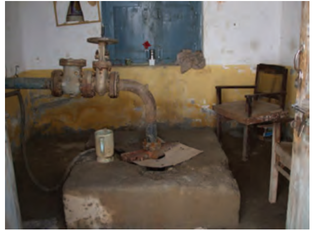
地下水システム：ジャンギ No. 1 の井戸ポンプ（水中モーターポンプ）は 1979 年に設置され、2005 年以來 4 回の修理を実施したが、老朽化が進んでおり、井戸ポンプの交換が必要となっている。
