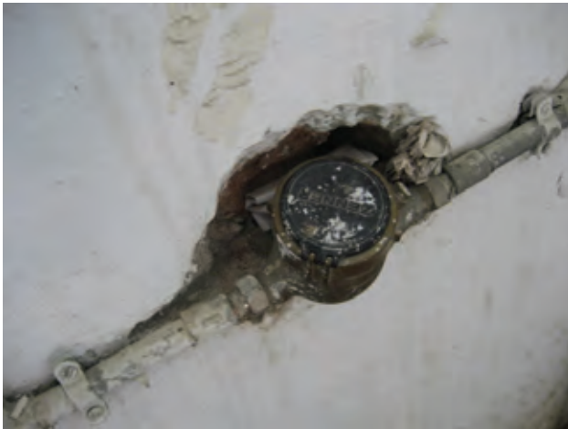
ナワンシェールサービスユニットで使用されているドイツ製の水道メーター。1998 年にドイツ復興金融公庫（KfW）による上水道改善事業により設置されたが老朽化が目立つ。
