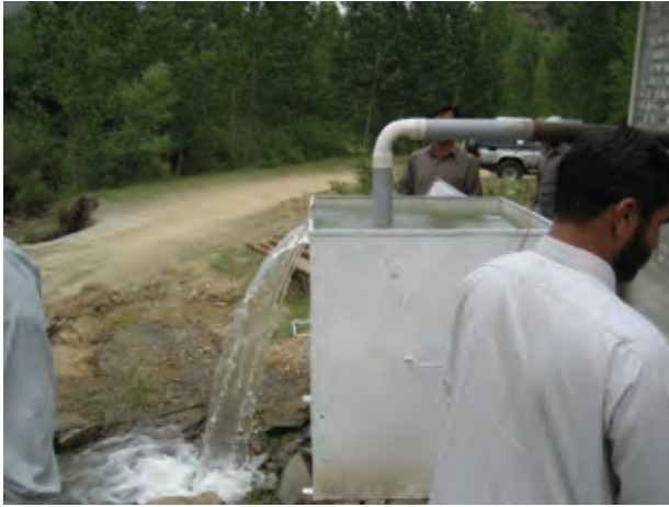
地下水システム：本調査によるデラワンダ No. 4 井戸での揚水試験。中央政府地震復興資金によって「パ」国側で掘削した井戸の1つである。
