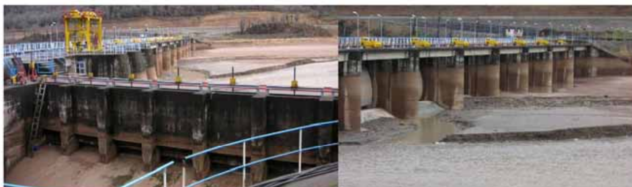
水路への取水口と水門前の堆砂状況、取水機能は維持されているが、貯水能力は極めて小さい。
