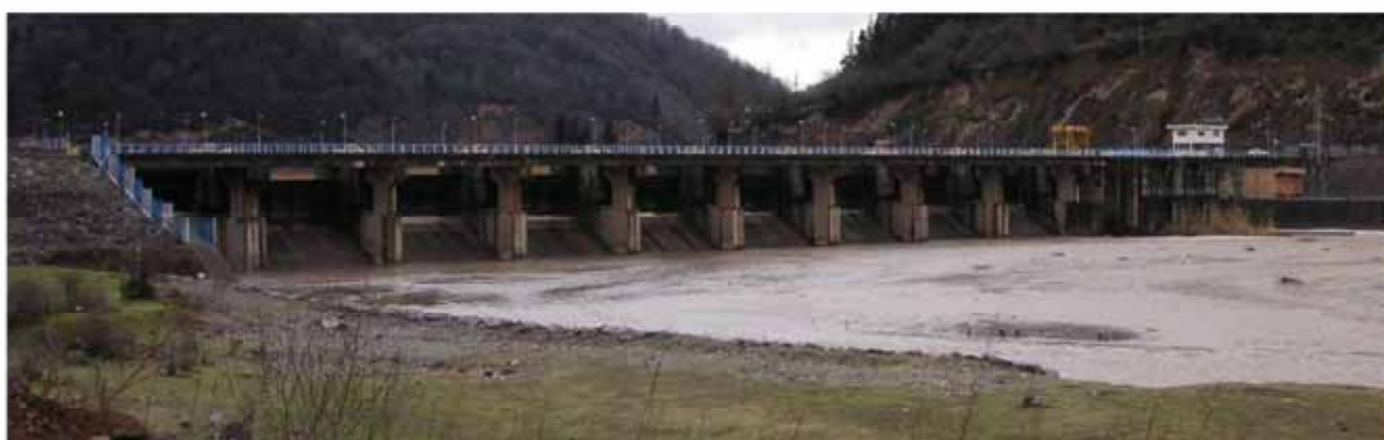
Gilan 灌漑用水の頭首工、Tarik Dam の下流側、排砂ゲートによる排水が行われており用水路への取水は行われていない。この頭首工からトンネルによる導水が行われ、ギラン地区左岸側の灌漑用水水源となっている。
