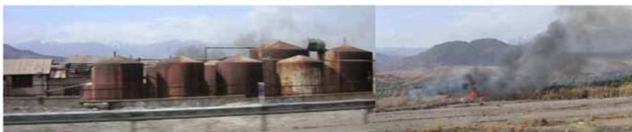
Sefid rud 川下流域では河川敷に隣接してかなり古い設備の工場群が立地しており、これらの工場からの未処理水の排水がダムの水質悪化の原因となっている。ダム上流域の工場等における排水管理や排
