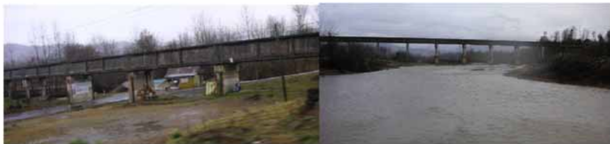
第一次幹線水路水道橋の平地および河川横断の状況。
