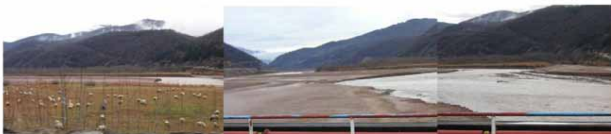
水路への取水口と水門前の堆砂状況、取水機能は維持されているが、貯水能力は極めて小さい。
