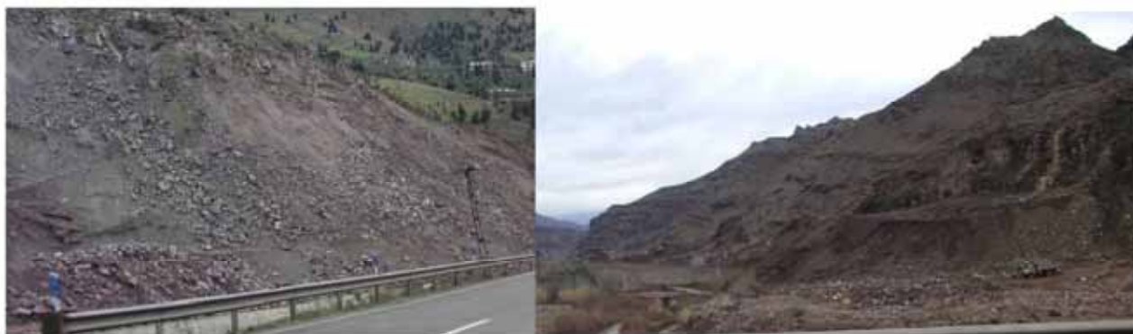
Molla Ali 川下流域における道路工事による山腹斜面掘削および土砂による河川敷の埋設の状況。
