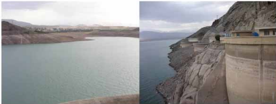
ダム湖の右岸側の市街地および左岸側の余水吐施設の状況
