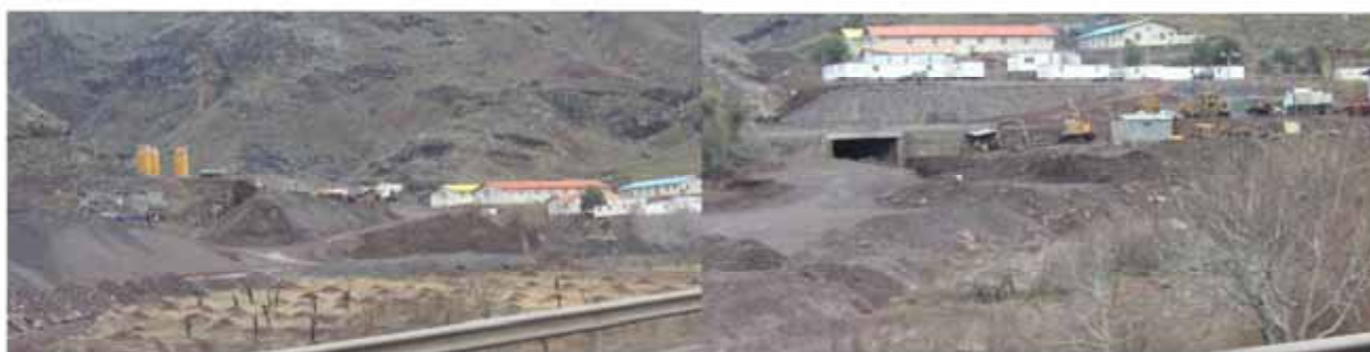
Shahrud 川下流域で河川敷に隣接する山腹で山砂の採石が行われており、これらの土砂が河川敷で貯留堆積されており、洪水とともに流下する可能性がある。
