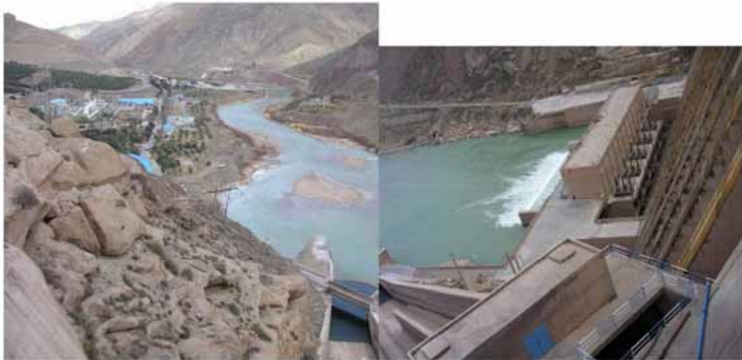
ダムの下流側河川および発電所の位置、余水吐の先に堆砂が見られる。
