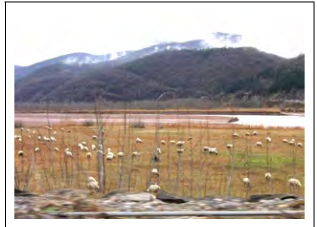
ダム下流の堆砂状況
