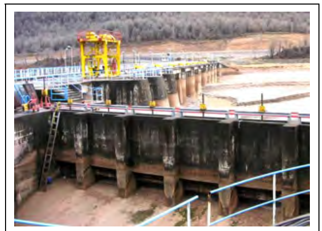
タリク頭首工（手前：取水口）
