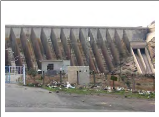
マンジルダム堤体下流側
