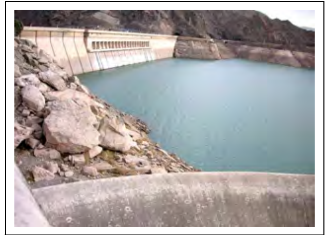
朝顔式余水吐（手前）とダム堤体上流側
