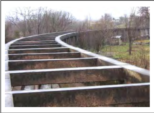
ギラン灌漑幹線水路
