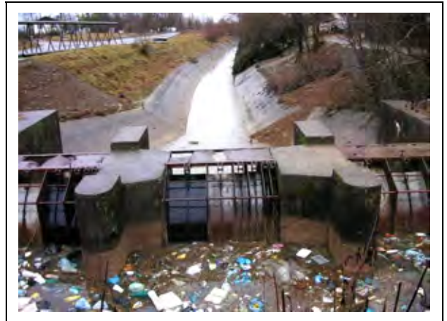
1次水路の水門と2次水路
