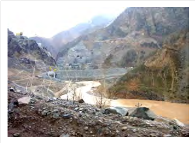
アスツールダム建設工事現場（上流側）
