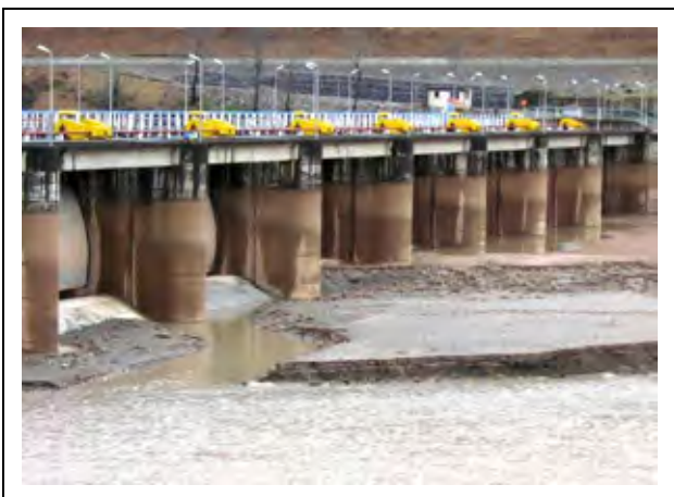
タリク取水堰と堆砂状況（上流側）
