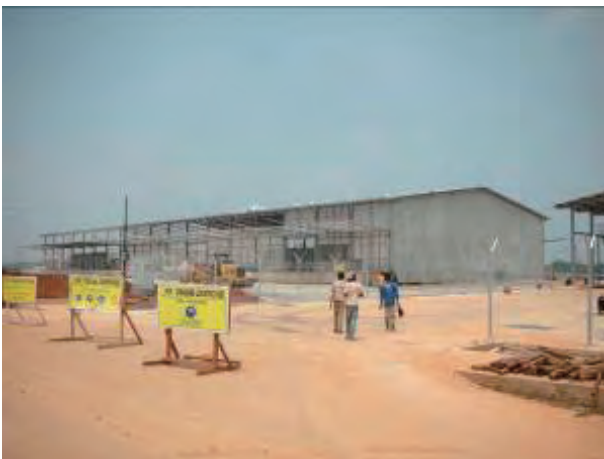
チカラン・ドライポート (倉庫建設中)
