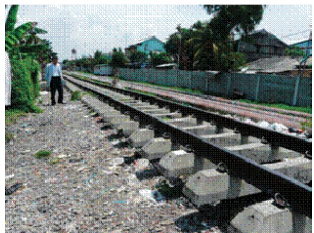
敷設済みの JICT アクセス軌道
