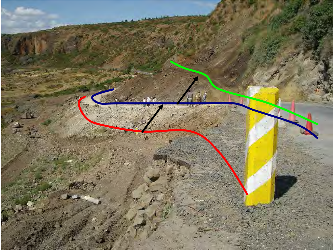
写真2 ステーション1における線形変更の状況
