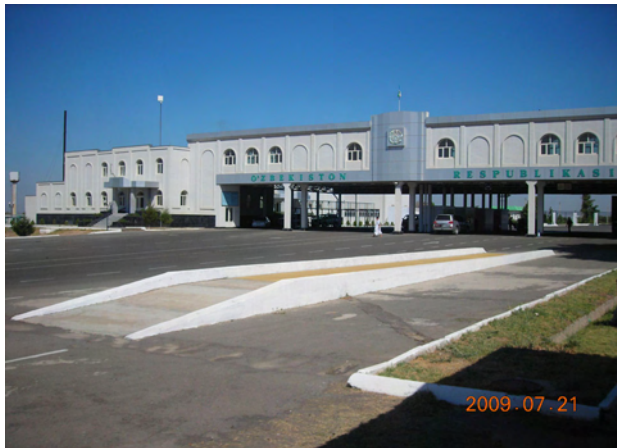
写真-1：アイト総合税関所。アフガニスタンからの入国ゲート付近から外観検査場を撮影。手前はトレーラー用重量計。
