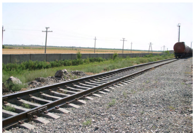
写真-9：ガラバ駅構内。14番線の機材据付予定場所付近。アフガニスタン、タジキスタン（手前側）より貨物車両が入線し、テルズ（向こう側）に向かう。
