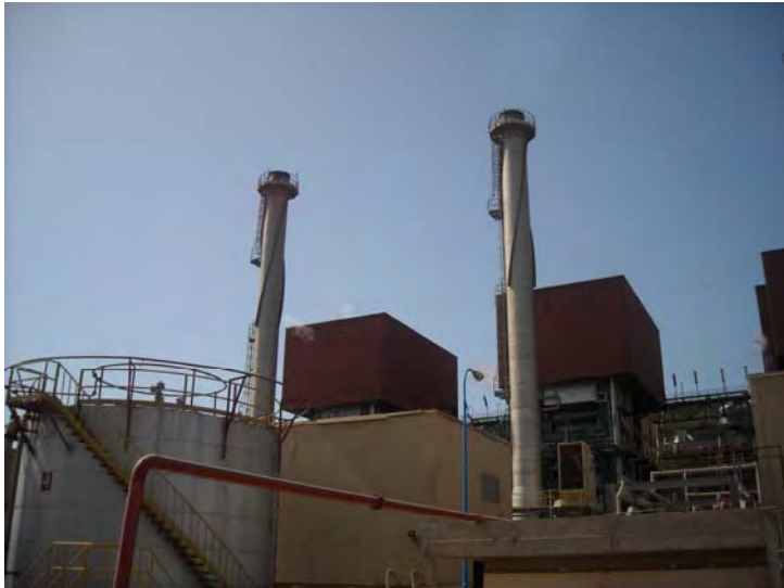
ラス・カトニブ汽力発電所
