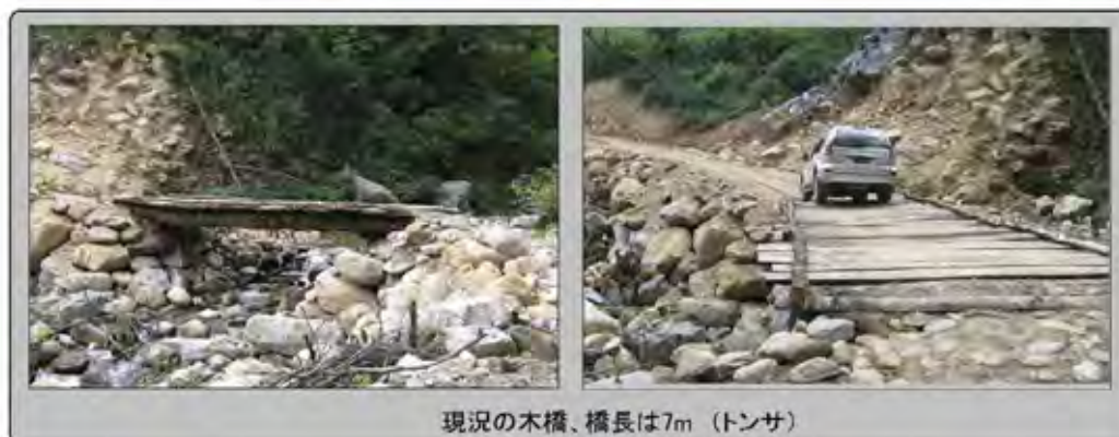
図 4.2-1 農村道路上の橋梁 丸太橋 車輛通行可能
