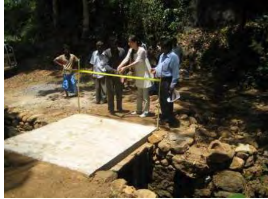
橋梁＋避難路整備
