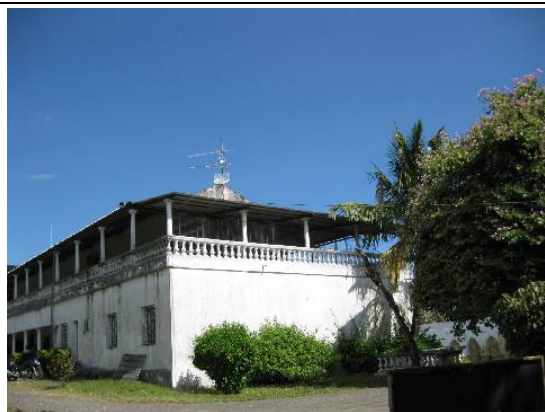
国立文書研究センターの屋根にはソーラーパネルが設置されている。
