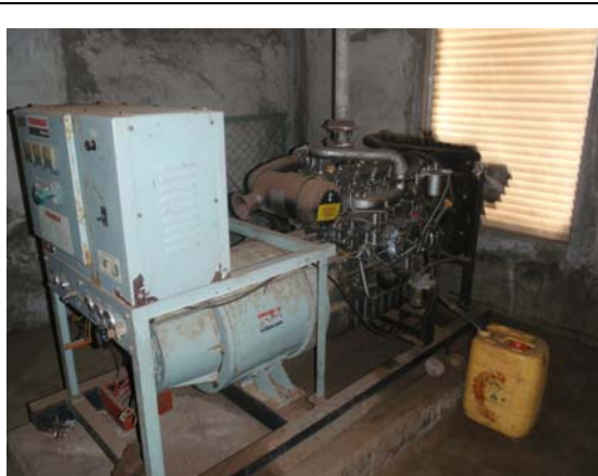
エンジンはかかるが機能していない発電機製氷機・冷蔵庫用非常用発電機。
