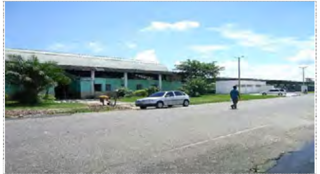
バスターミナル敷地現況写真
