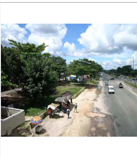
敷地現況写真(右側)
