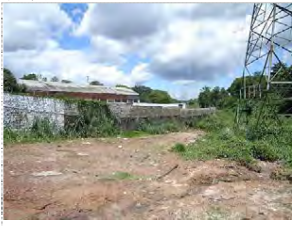
敷地現況写真(左ランプ用地)
