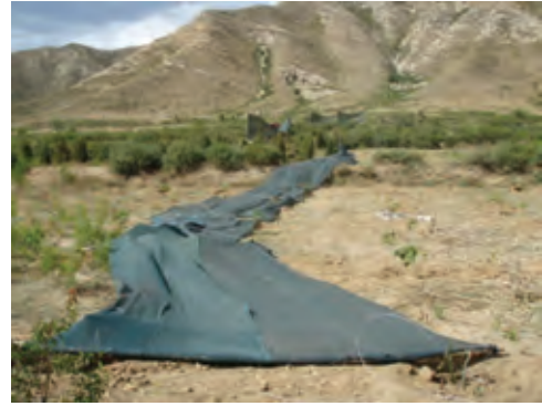
图 7-3-2 柱子太弱防风网倒塌
