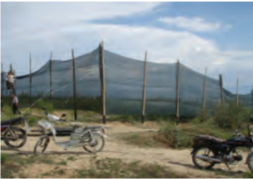
图 7-3-3 加强柱子缩短间距再设置
